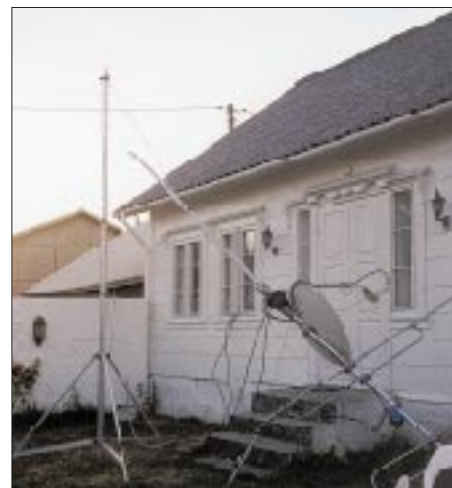
„Schnellabbau“ der Antennenanlage durch einen norwegischen Sommersturm
